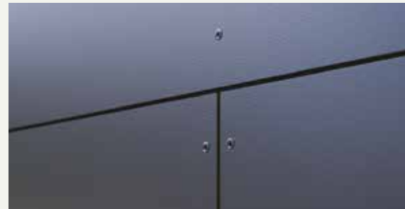
1. Rockpanel Høy dimensjonsstabilitet gjør det mulig med smale skjøter mellom platene.
