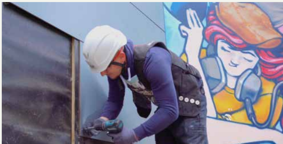
Enkel demontering av Rockpanel plater
