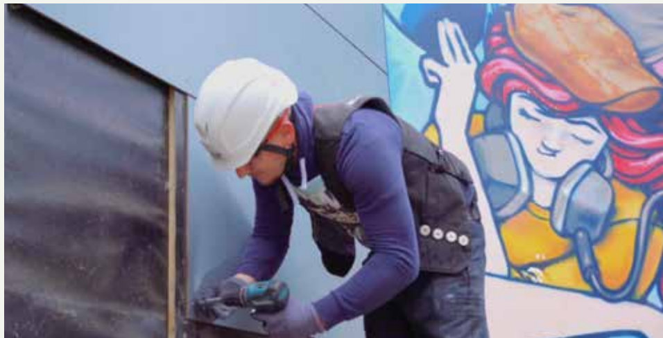
Nem afmontering af Rockpanel plader
