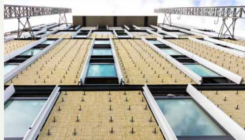
En stenuldsisolering virker effektivt mod temperaturudsving og støj
