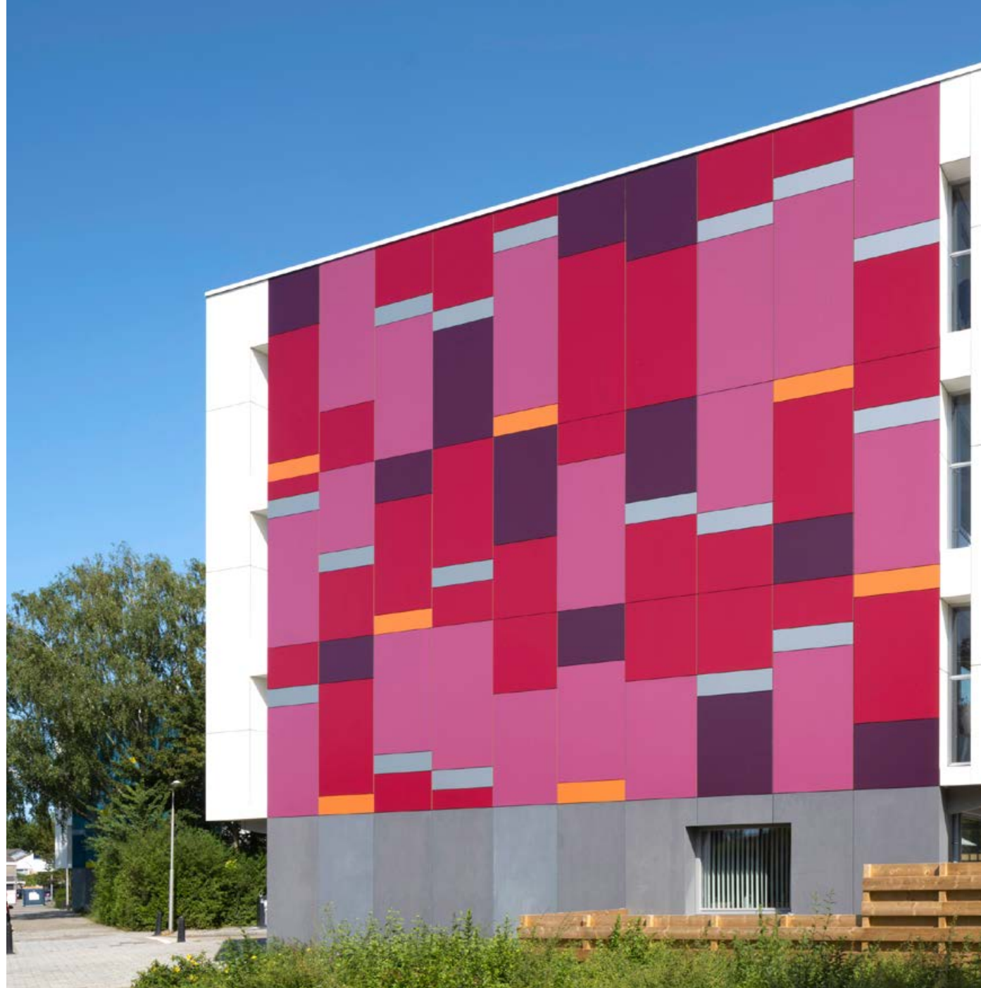
Projekt: Renovierte Mehrfamilienhäuser, Emmeloord, Niederlande
