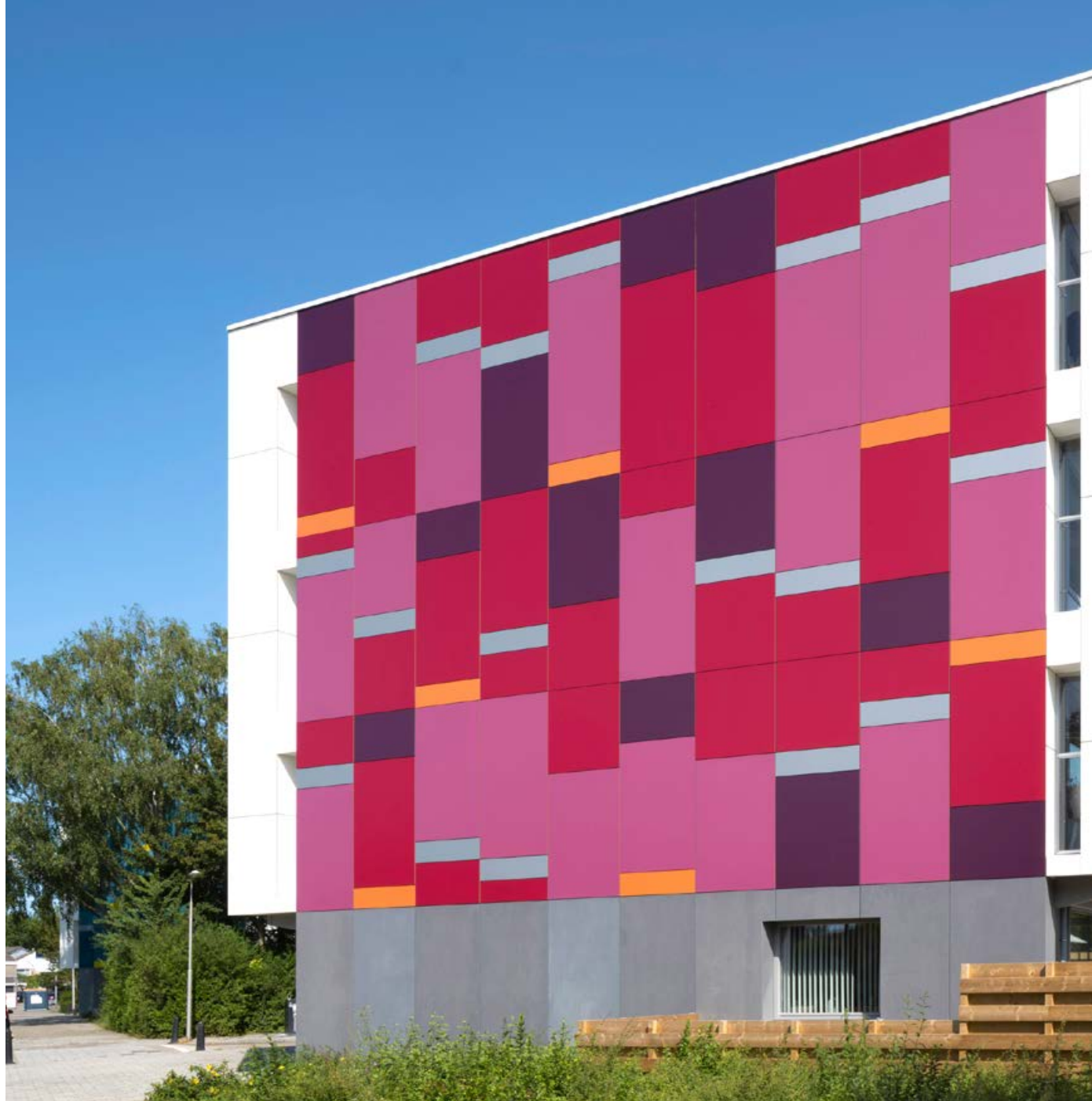
Projet : Appartements rénovés, Emmeloord, Pays-Bas
