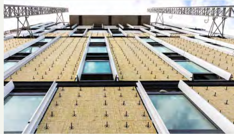
L'isolation en laine de roche est efficace contre la chaleur et le bruit
